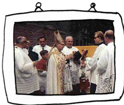
3. Oktober 1964 | Grundsteinlegung für das Pfarrheim, das in der Baulücke in der Blindengasse das Pfarrhaus ergänzen wird.
